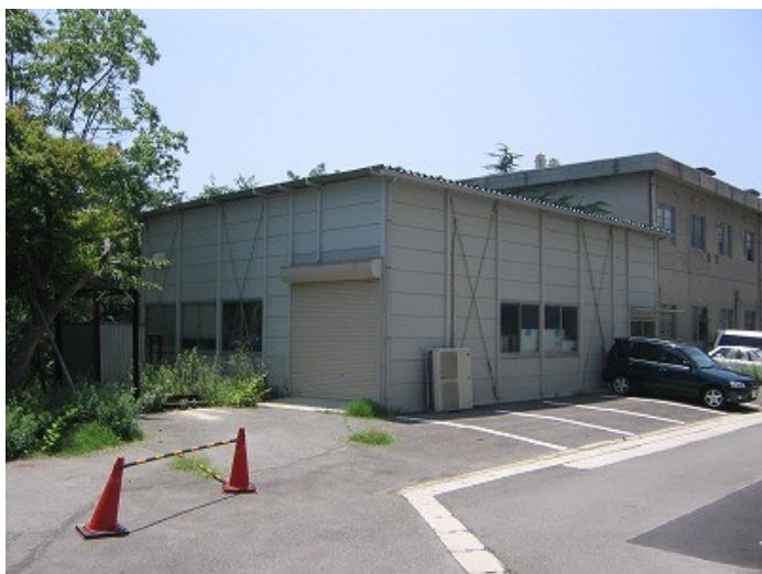
宇宙線検査小屋(外観)
